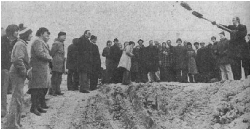
Der erste Spatenstich zum Wohnheim 1995
